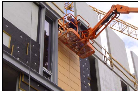
Detail van een testopstelling om de uitvoeringsmethodiek te testen (plaatsing thermische isolatie - luchtdichtheid)
