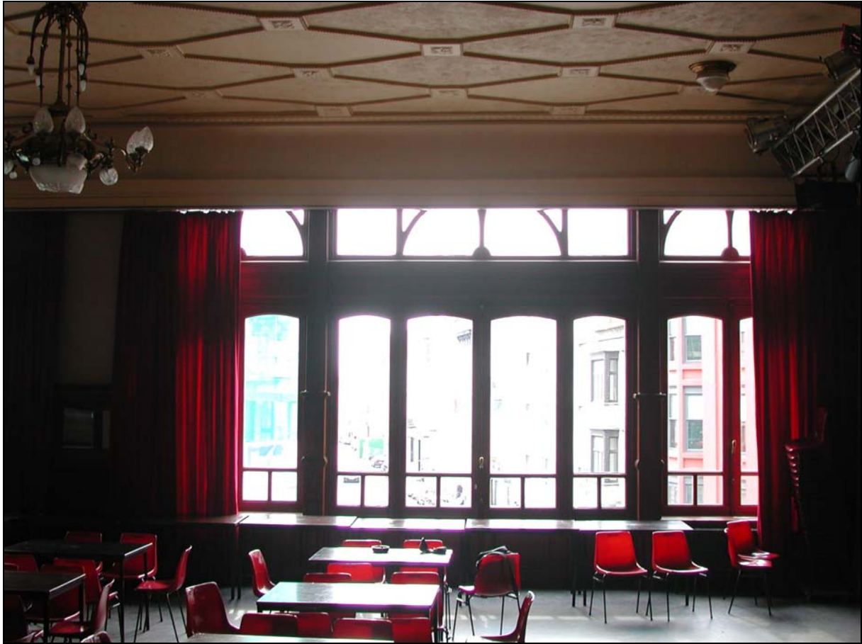
Bestaande toestand: historische voorgevel met grote houten raampartijen
