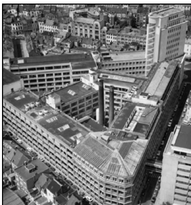
Den Bell vóór de renovatie
