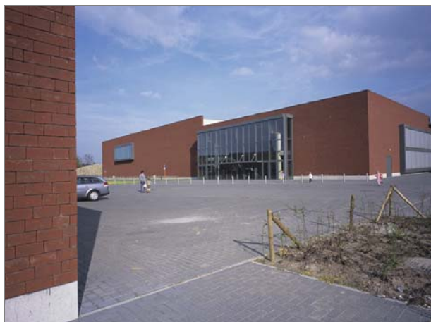
Multifunctionele sporthal, voorgevel, hoofdtoegang
