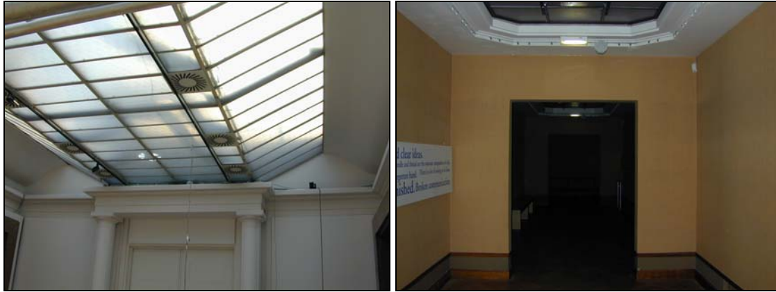
Foto's 7-8. Zicht op de dakstructuur en oorspronkelijke binnenbekleding van de wanden
