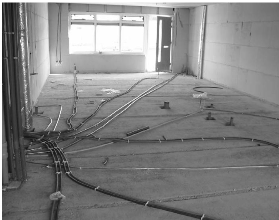
FIGUUR 3. PRAKTIJKVOORBEELD ; DRAAGVLOER MET VERSLEEPT LEIDINGEN VOOR HET AANBRENGEN VAN DE ZWEVENDE DEKVLOER
